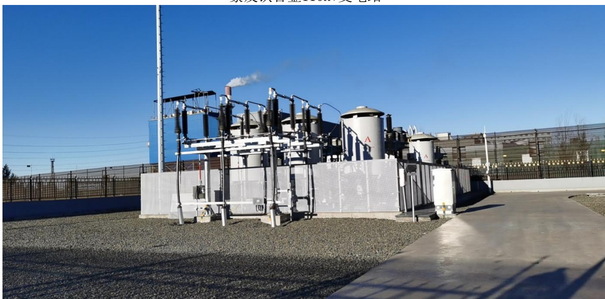
蒙发铁合金110kV变电站主变等户外装置
